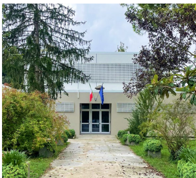
2024 RIQUALIFICAZIONE ENERGETICA SCUOLA ARCA DELLE COLLINE PESARO
